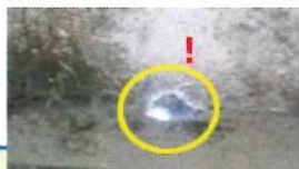
壁や床の破損がないか(外の光が漏れている所は要注意)
