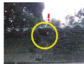
防鳥ネットの破れがないか
