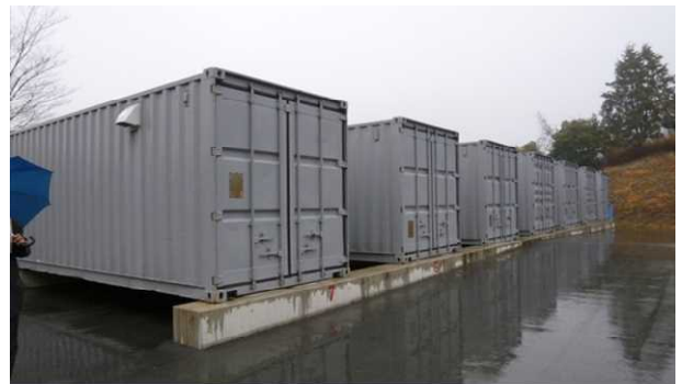
写真1 防疫資材備蓄コンテナ(外側)
