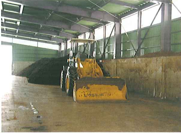
写真3：堆肥舎・堆積場とショベルカー
