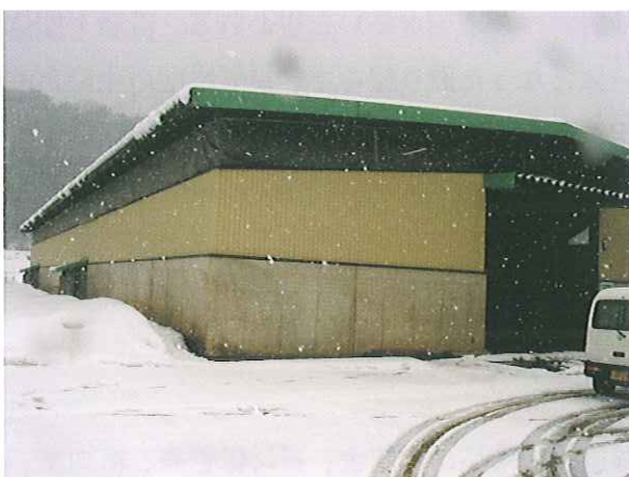
写真1：堆肥舎・外観
