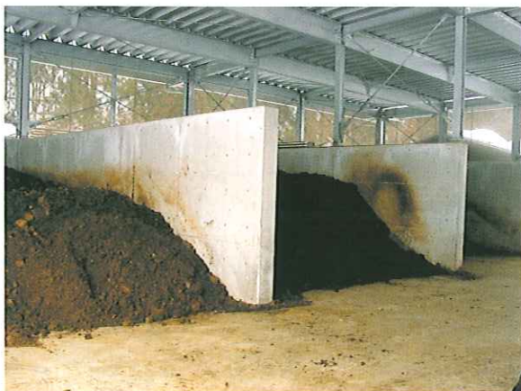
写真6：堆肥舎・一次処理槽
