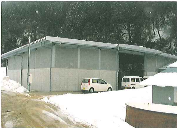
写真5：堆肥舎・外観
