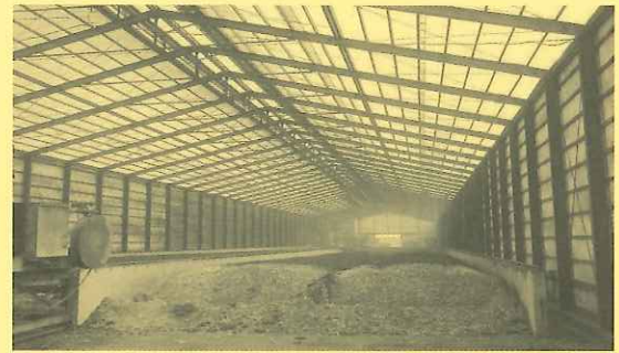
写真4 幅16m長さ80mの醗酵層の投入側内部
