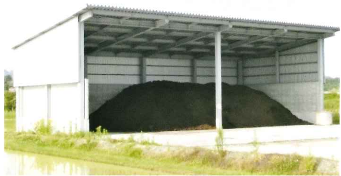
写真 6 町外に設置した堆肥保管庫
