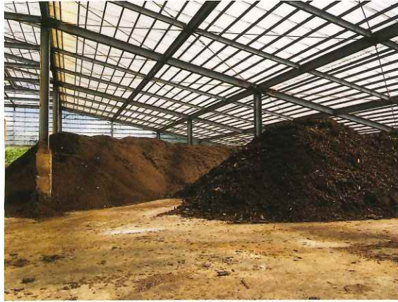
写真1 堆肥化処理施設内
