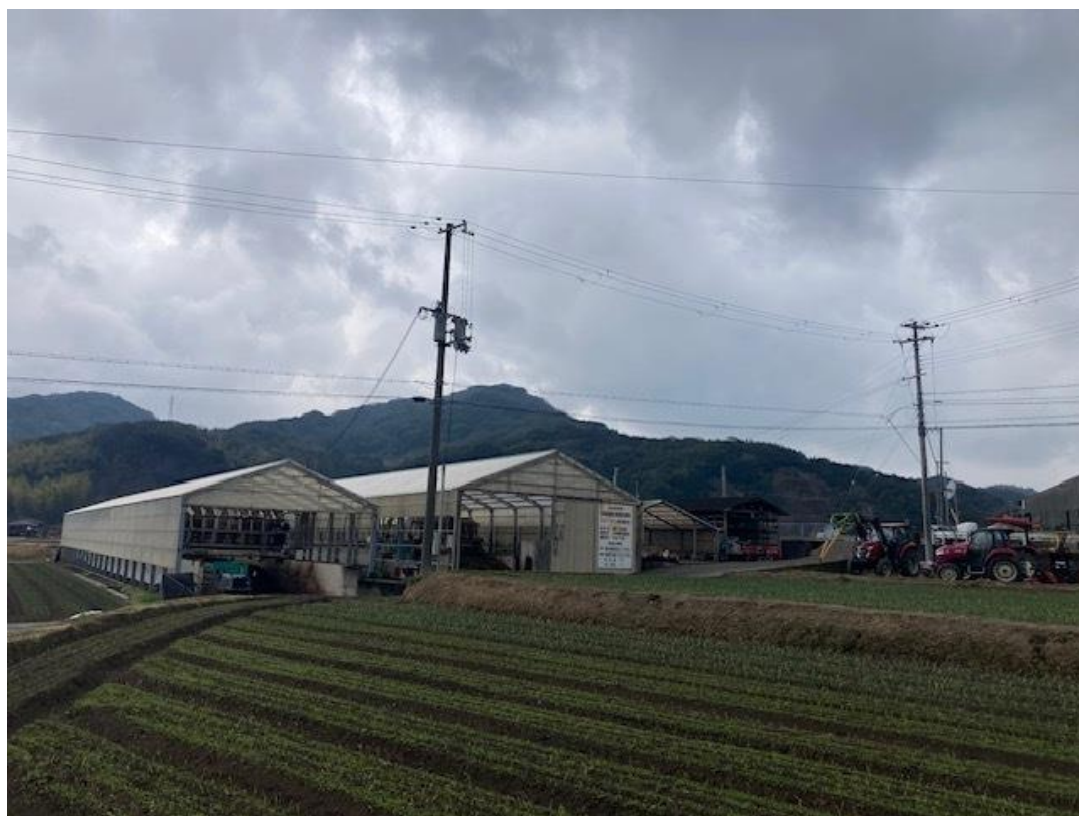
堆肥化处理施設
